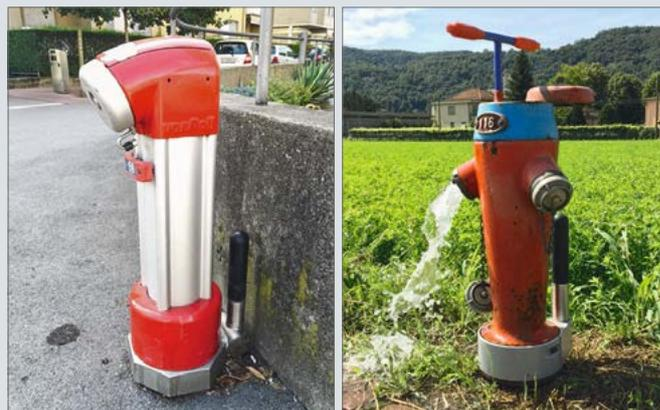
Il trasmettitore del sistema di monitoraggio di Rancate è visibile alla base degli idranti.
